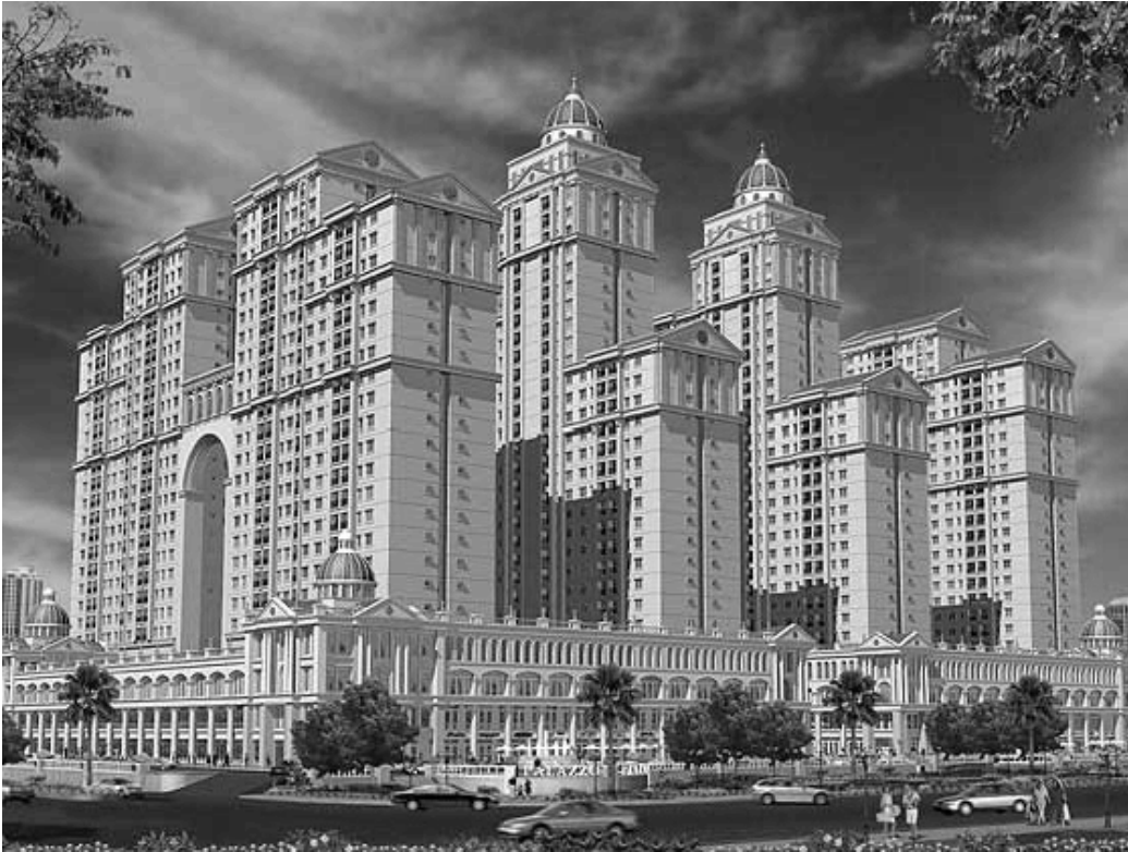
Abbildung 4: Im Bau befindliche Appartementkomplexe
